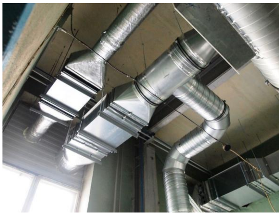
Производство элементов вентиляции.
